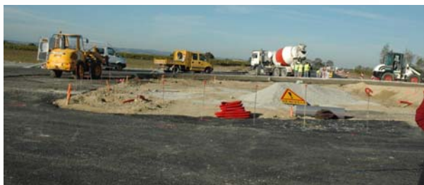
Une vue du chantier
